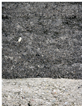
Mur en béton de mâchefer sur un soubassement en béton "classique"
