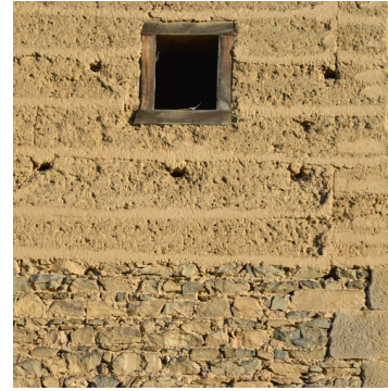
Mur en pisé et soubassement en pierre
