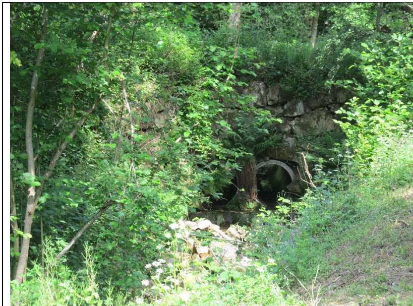
Photo 1 : ouvrage de franchissement - vue vers amont – Commune de Saint-Julien-Vocance
