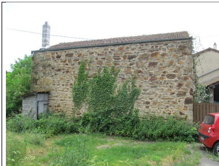
Photo 52 : construction en zone inondable – vue vers l'aval – ruisseau de la Garinière – Commune de Saint-Marcel-lès-Annonay
