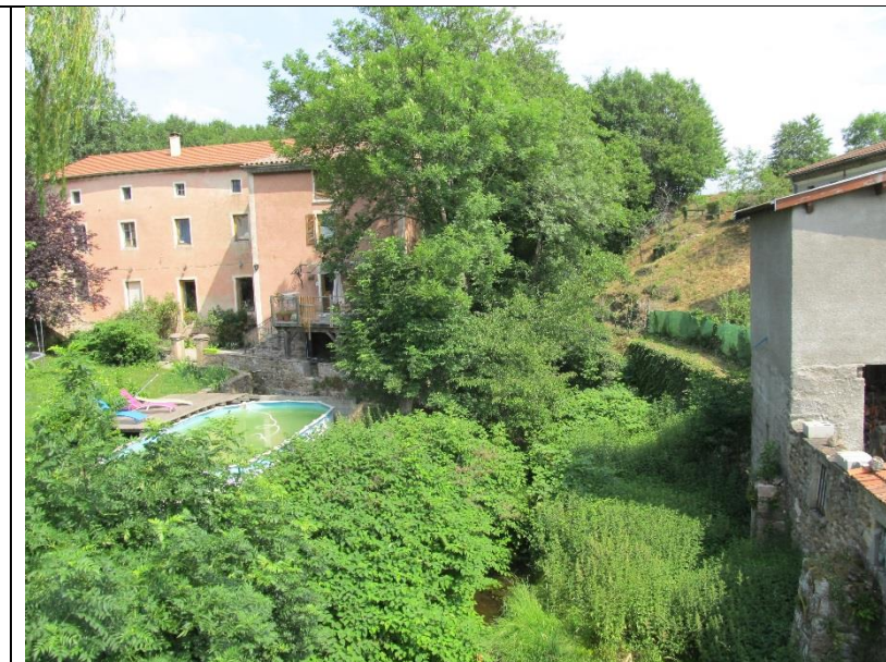
Photo 35 : maisons en zone inondable - vue vers l'amont - Commune de Maclas
