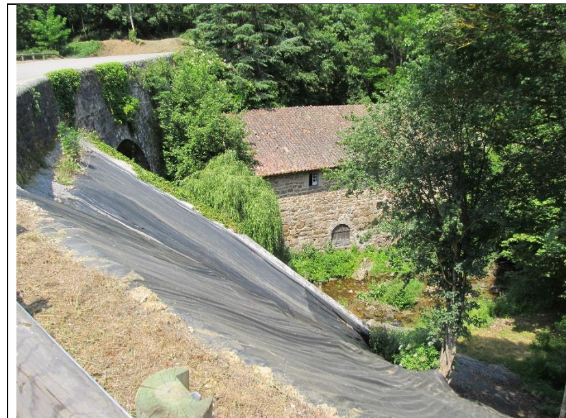
Photo 10 : vue vers l'aval depuis la route - Commune de Vanosc
