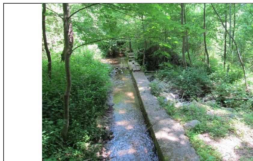
Photo 8 : prise d'eau vue depuis la rive droite - Commune de Vanosc
