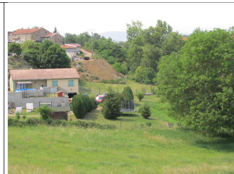
Photo 14 : maison à cheval sur le talus hydrogéomorphologique et remblai en zone inondable – Eterpas le Bas – Commune de Saint-Cyr
