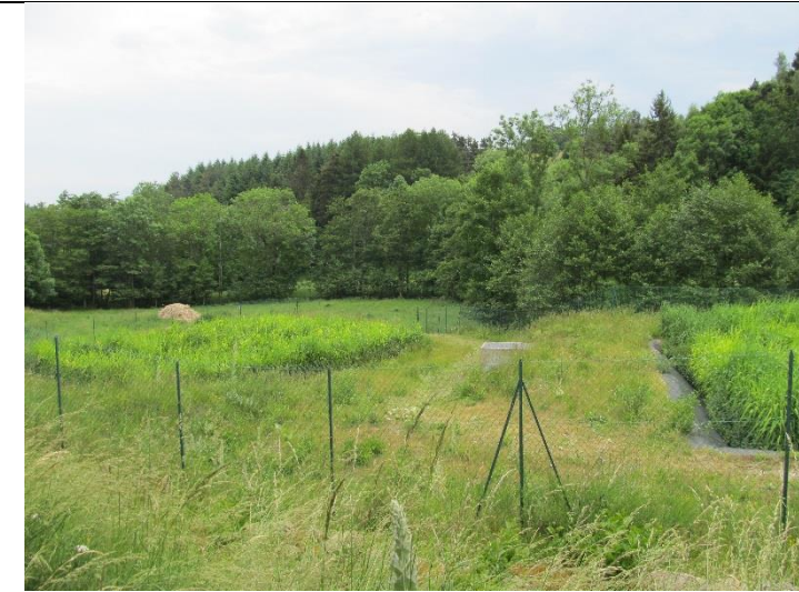
Photo 49 : ancien talus hydrogéomorphologique, remblai de la step - rive gauche - Commune de la Versanne
