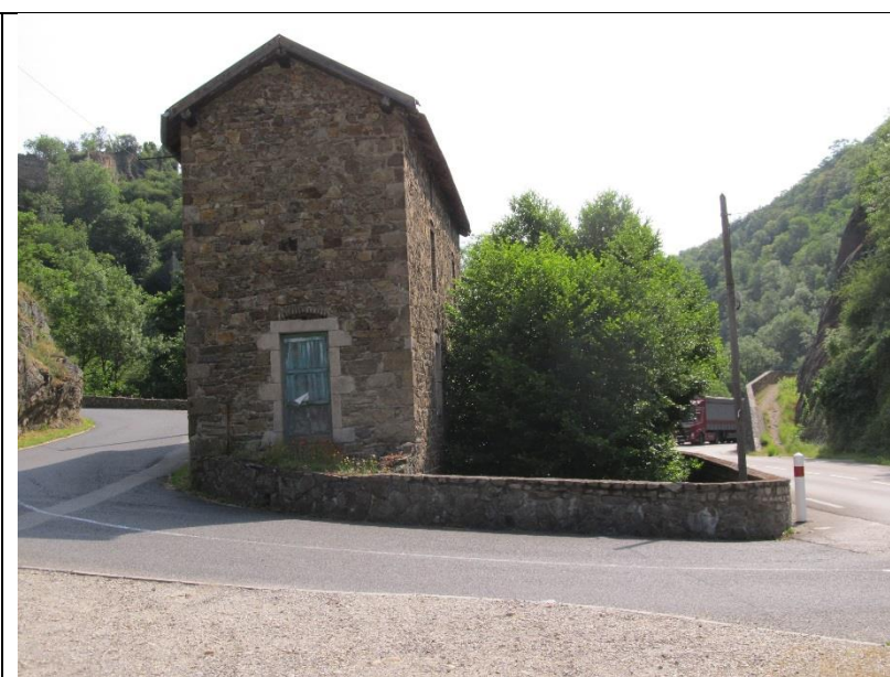
Photo 32 : construction en zone inondable - vue vers l'aval – Commune de Malleval
