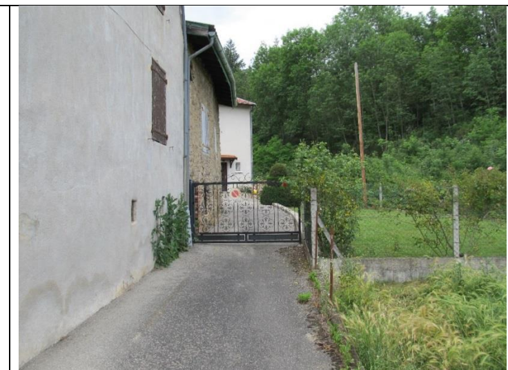
Photo 51 : maison en zone inondable vue vers amont – ruisseau de la Garinière – Commune de Saint-Marcel-lès-Annonay
