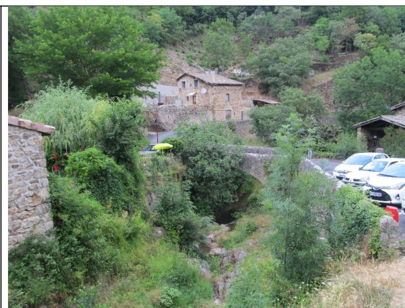
Photo 16 : vue vers l'aval en rive droite – confluence Torrenson/ruisseau d'Ozas – centre-bourg – Commune de Thorrenc
