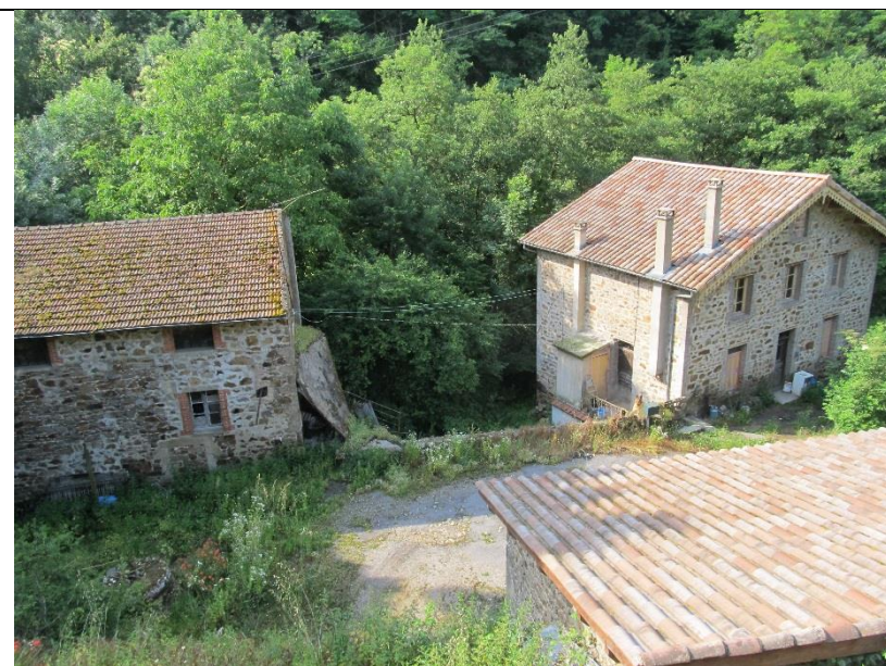
Photo 28 : vue depuis la rive gauche - maisons en zone inondable - Commune de Pélussin
