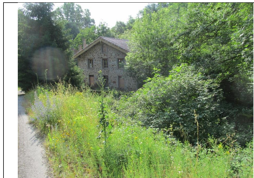
Photo 27 : partie de la maison en zone inondable - vers aval - rive gauche - Commune de Pélussin
