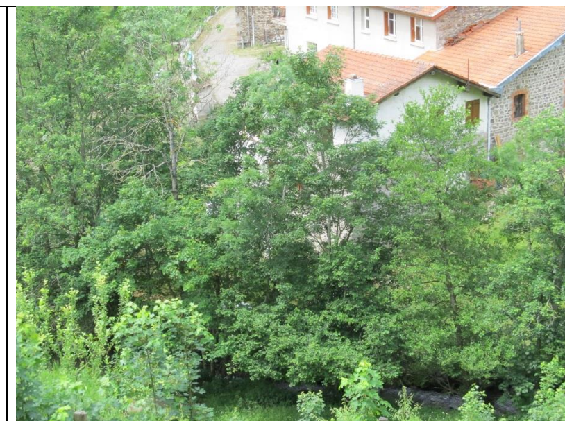
Photo 44 : nouvelle construction en zone inondable vue depuis la rive gauche - Commune de Thèlis-la-Combe
