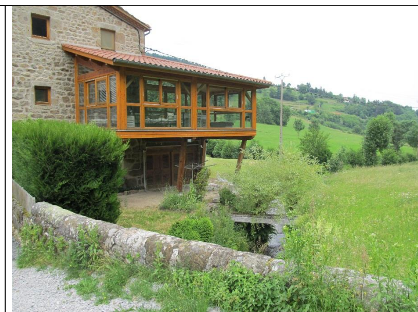
Photo 46 : maison en zone inondable - vue vers l'aval - Commune de la Versanne
