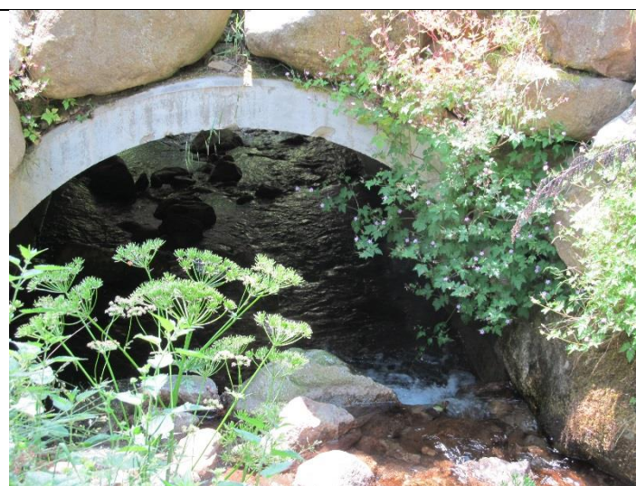
Photo 9 : ouvrage cadre vue vers aval – Pont de Moras – Commune de Vanosc
