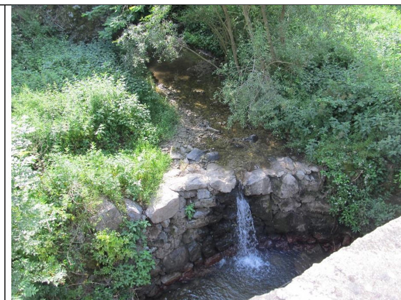
Photo 30 : seuil en amont de l'ouvrage du pont RD503 – Commune de Malleval
