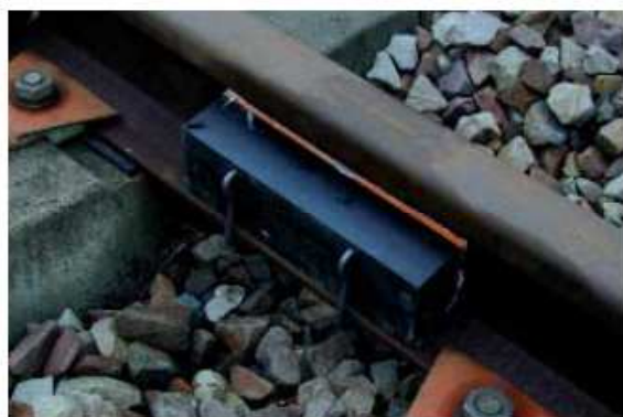
Exemples d'absorbeurs sur rail (Corus et Socitec)
