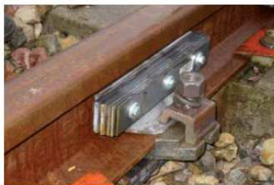
Exemples d'absorbeurs sur rail (Corus et Socitec)
