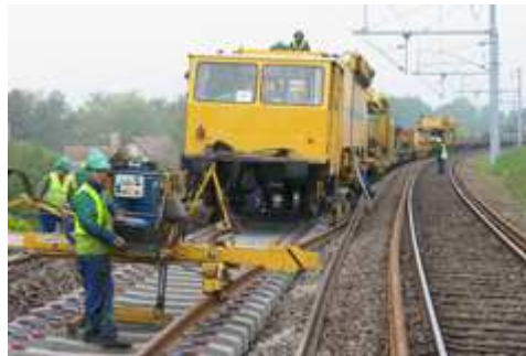
Rails soudés sur traverses béton
