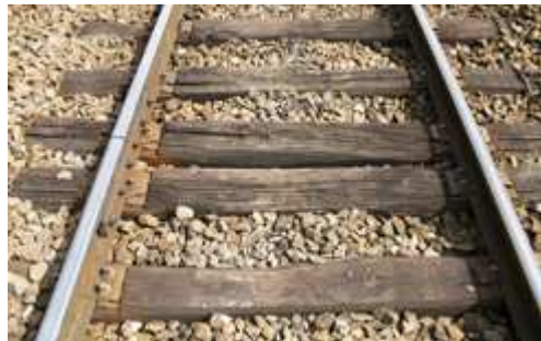
Rails courts sur traverses bois longs
