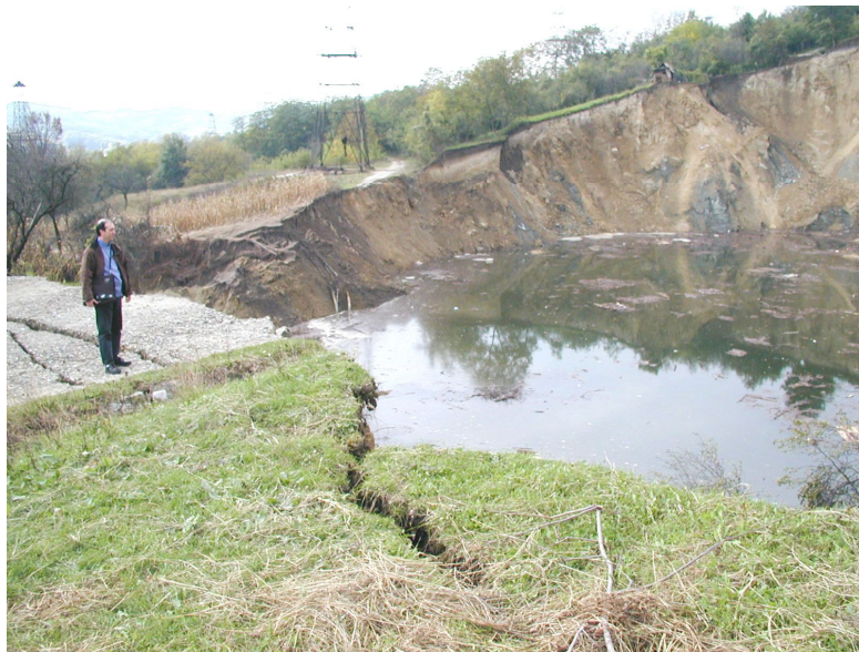
Photo 4 : L'effondrement partiel de la caverne d'Ocnele Mari (Roumanie), le 8 octobre 2001, a provoqué une vague qui a causé des dégâts importants aux installations et habitations situées à l'aval.
