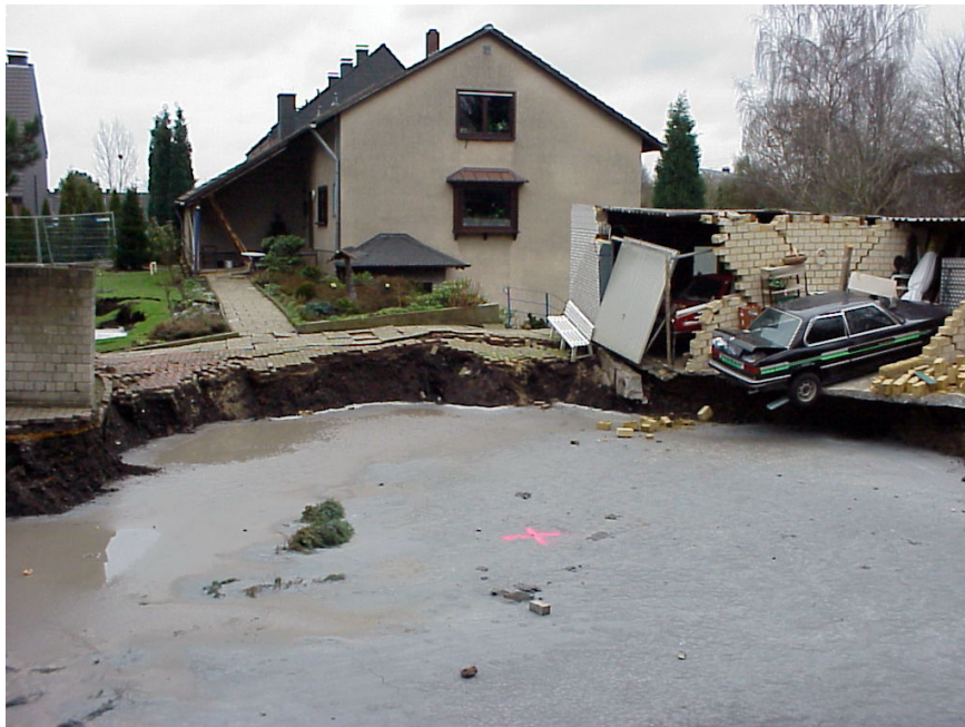
Photo 7 : Effondrement d'une tête de puits en Allemagne.
