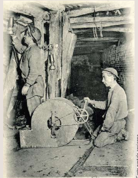
Mineurs recherchant les arrivées de grisou.
