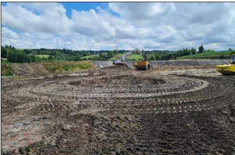
Figure 28 : Barrière de sécurité passive du casier amiante en cours de réalisation (Source : SCE)
