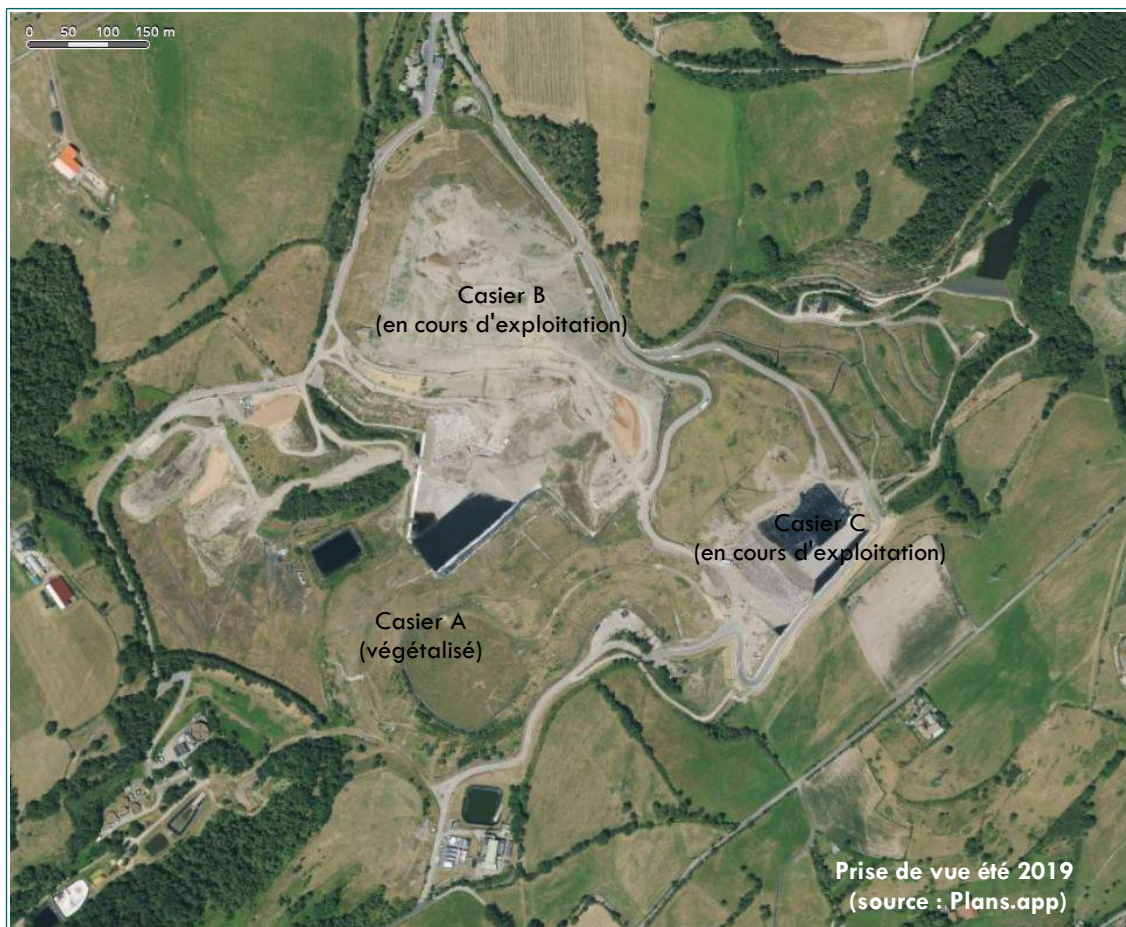
Illustration 1 : Vue aérienne de l'ISDND (situation 2019)
