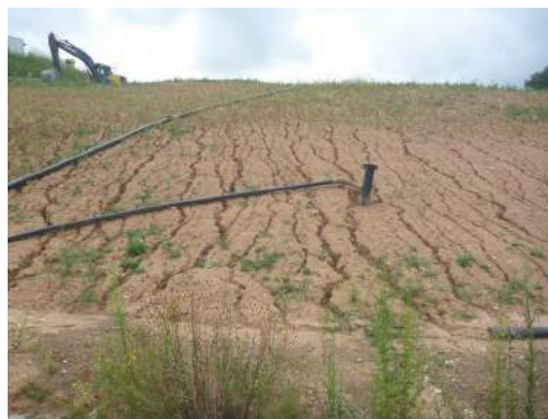
Couverture terreuse ruissellant vers le bassin Est 2
