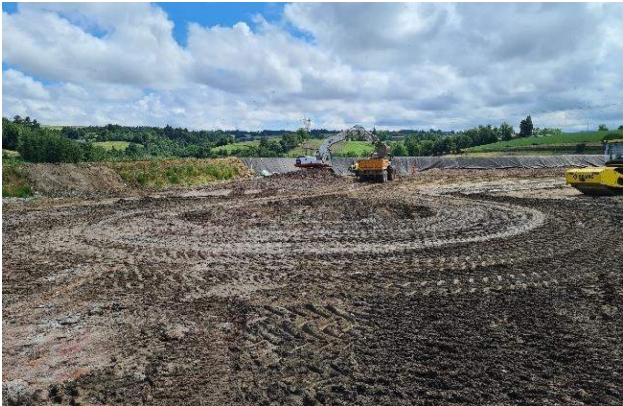
Figure 1 : Barrière de Sécurité Passive du casier Amiante n°3 en cours de réalisation (juin 2021 – source SCE)
