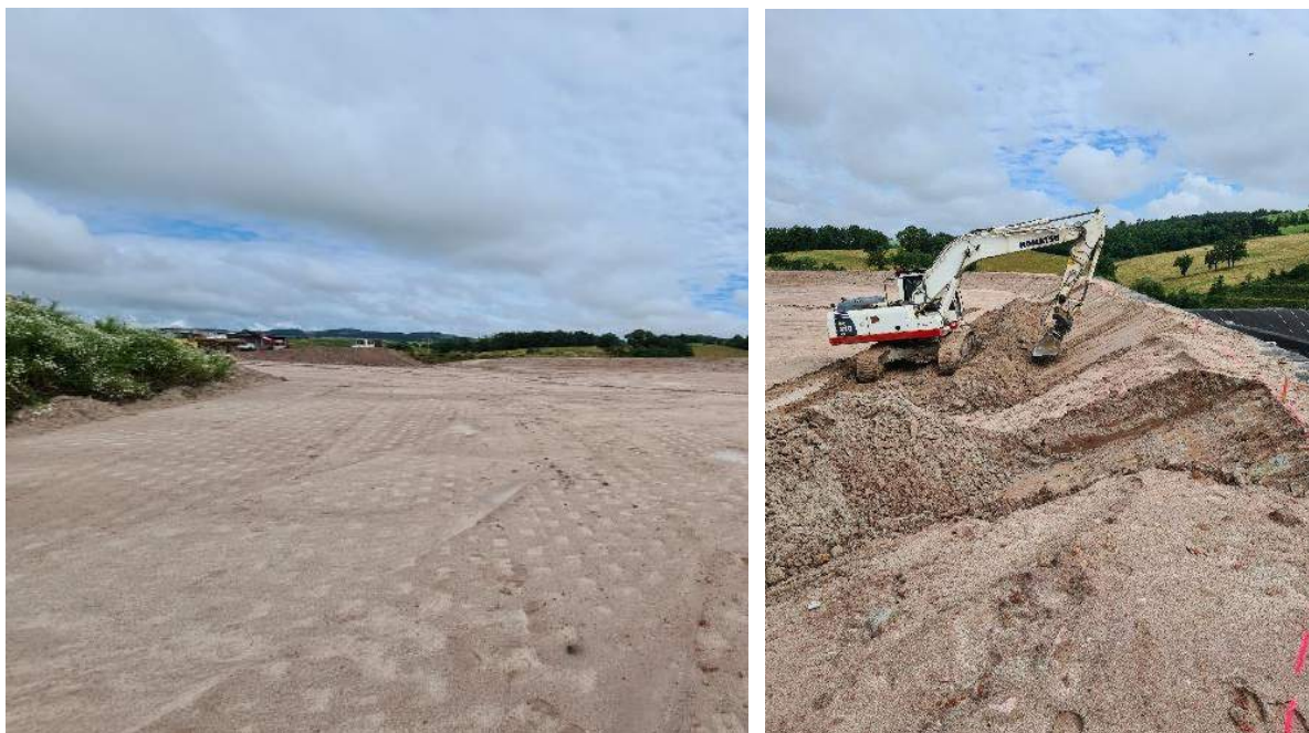
Figure 3 : Barrière de Sécurité Passive du casier amiante n°3 en cours de réalisation (fond de forme à gauche et talus à droite) – juin 2021- source SCE.
