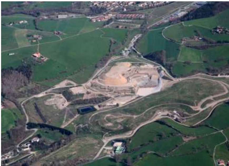
Vue aérienne du site (Internet)
