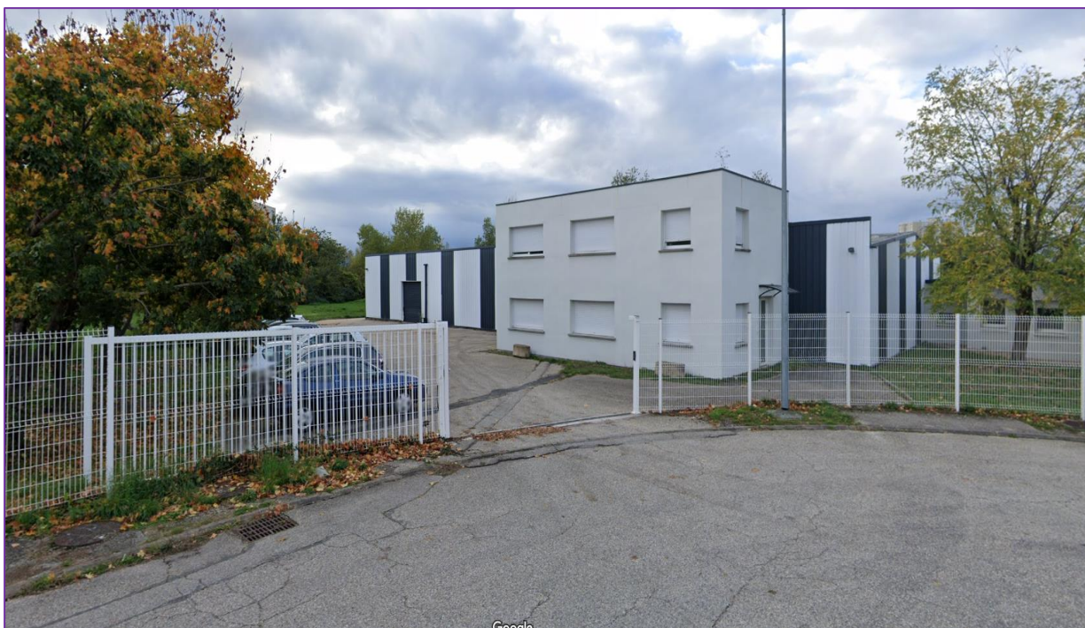
Entrée du site HEF M&S Services
