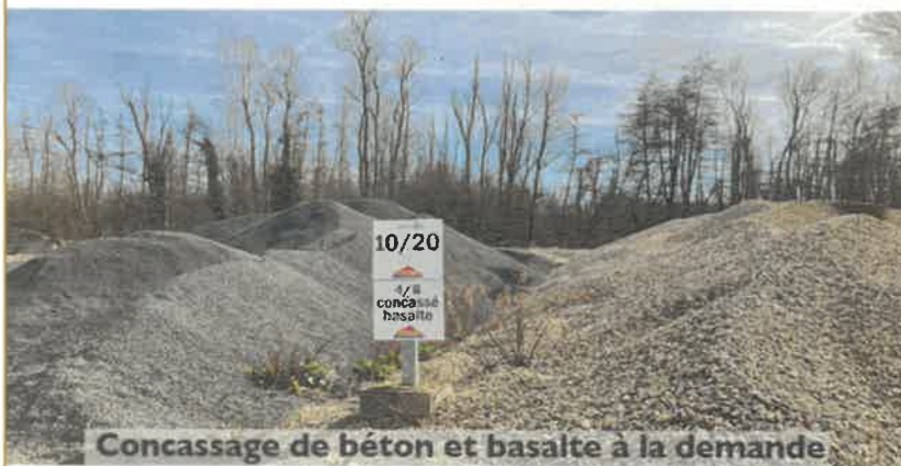
Traitement des matériaux en extérieur et sous hangar
